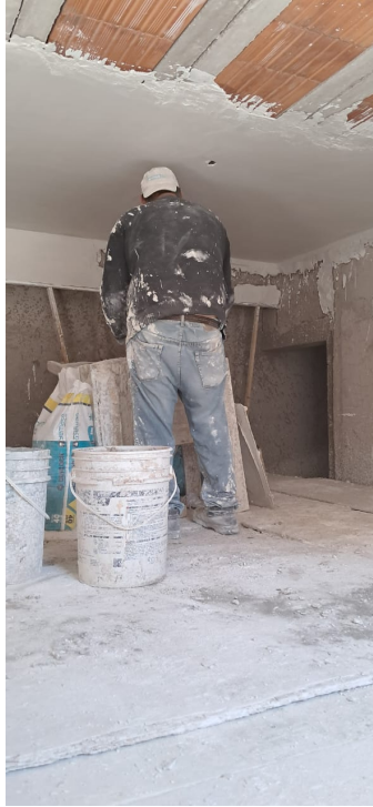
Imagen N° 6: Riesgo de proyección de partículas. Se observa operario sin los EPP. Fuente: CP/ Cassanelli Pamela, 2025.
