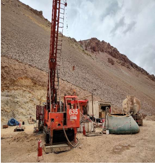
VISTA GENERAL DEL POZO
