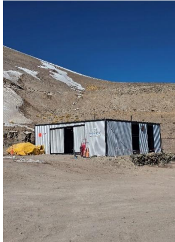
Figura 27 Sector de generadores. Fuente: Elaboración propia a partir del trabajo de campo (2026)
