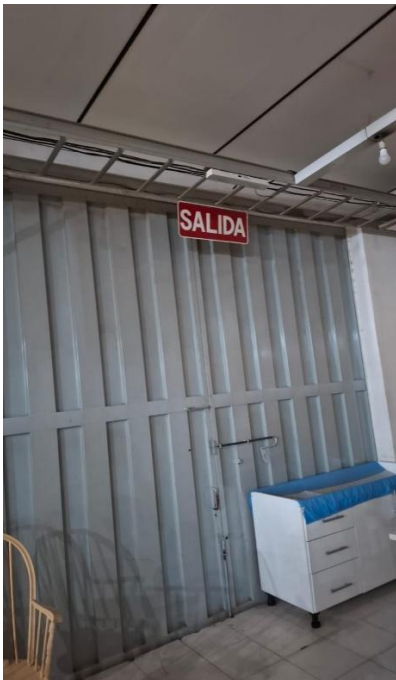
Figura N°2: puerta de salida de emergencia cerrada con llave. Fuente: R.M 2025
