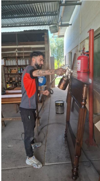
Figura N°4 operario sin elementos de protección personal con soplete. Fuente: R.M AÑO 2025
