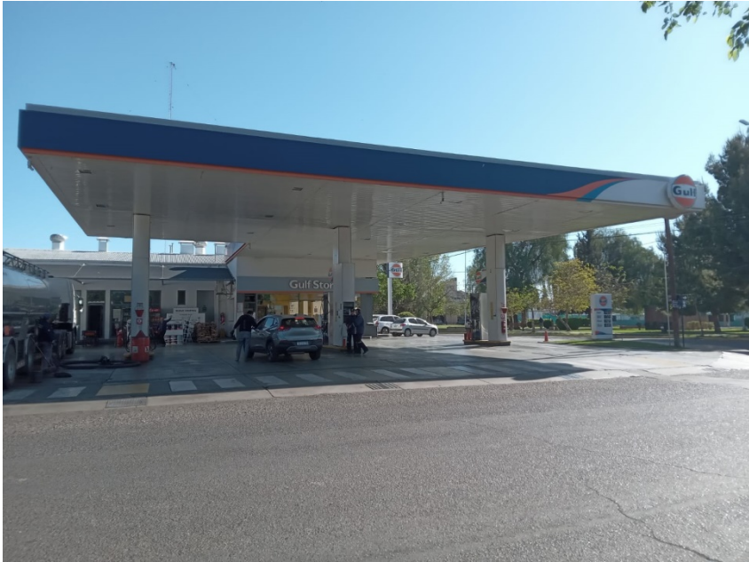
Figura N° 11: Fachada de la estación de servicio Gulf Oil. Fuente: A.F. (2025)
