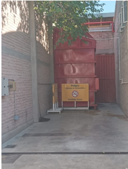
Figura N°22: Señalización de estación de servicio. Fuente: A.F. (2025)
