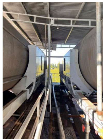
Figura 4: Prensa Neumática de Bodega y Viñedos Benedetti (Fotografía propia).
