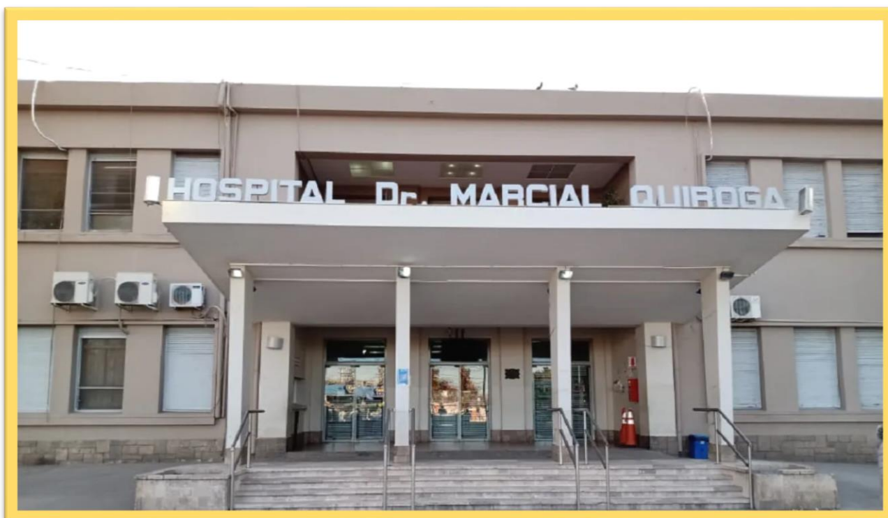
Figura N° 6: Entrada principal por calle Libertador – Edificio Viejo
