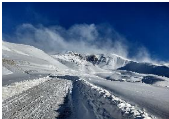
Fig. 7 Camino acceso a Fase 6- Obra Ampliación Valle de Lixiviación.
