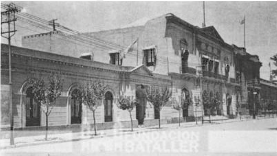
Calle General Acha, antes del terremoto de 1944, muestra a la izquierda, parte del edificio que ocupaba la Legislatura provincial. Al lado, de dos plantas, se ve impecable el edificio de la Casa de Gobierno, con su acceso con escalinatas y su balcón.
